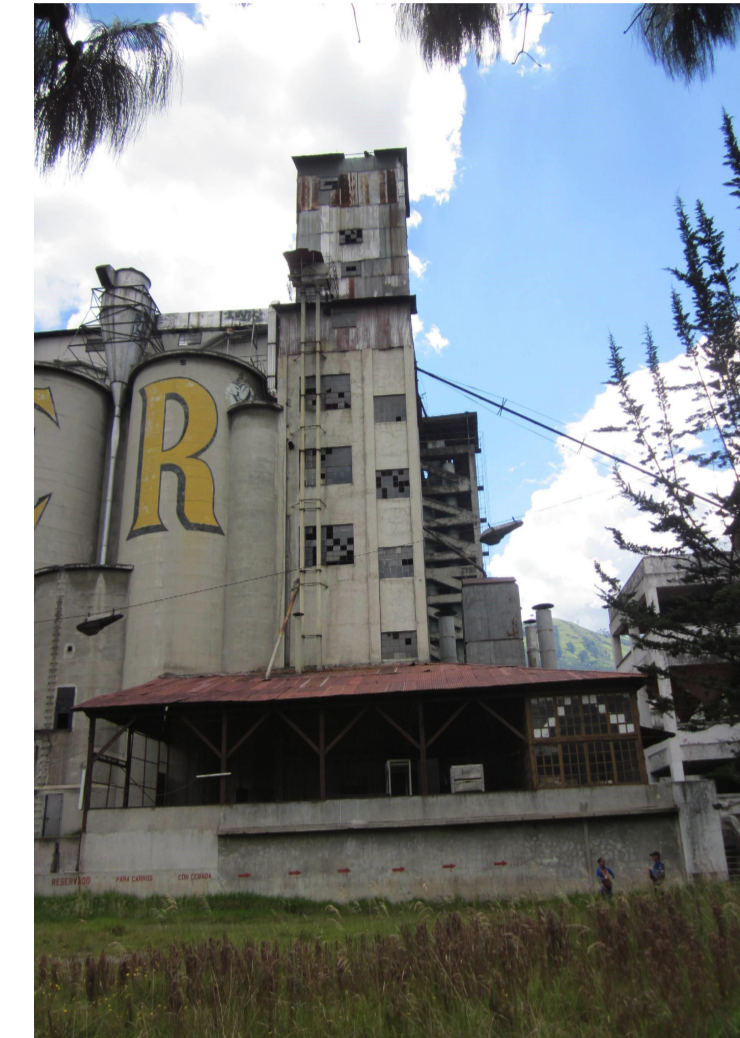
Imagen cuarto de maquinas
