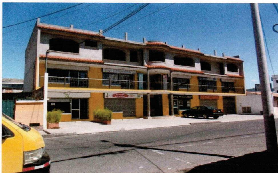
CALLE JOSE JOAQUIN OLMEDO (F-20): CONSTRUCCIÓN DESARROLLADA EN TRES PLANTAS, ESTRUCTURA DE HORMIGÓN ARMADO, PAREDES DE BLOQUE ENLUCIDO, CUBIERTA DE LOSA PLANA CON DETALLES EN LA PARTE FRONTAL DE CUBIERTA
