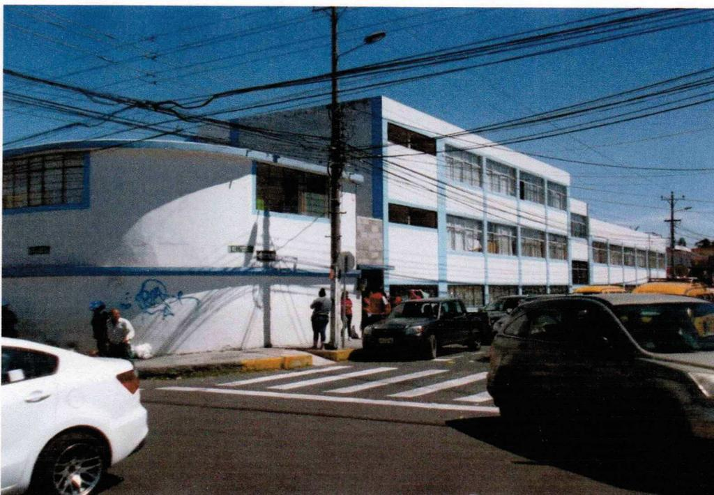
INTERSECCION CALLE MARISCAL SUCRE Y SIMON BOLIVAR (F-19): ENCONTRAMOS LA UNIDAD EDUCATIVA LUCIANO FRANCO DE CASTRO, QUE ESTÁ CONSTRUIDA TOTALMENTE CON HORMIGÓN ARMADO, PAREDES DE LADRILLO ENLUCIDO, CUBIERTA DE LOSA PLANA, EN LA PARTE FRONTAL ENCONTRAMOS UN EDIFICIO DE TRES PISOS, CONSTRUIDA DE HORMIGÓN ARMADO, PAREDES DE BLOQUE ENLUCIDO Y CUBIERTAS DE LOSA PLANA.
