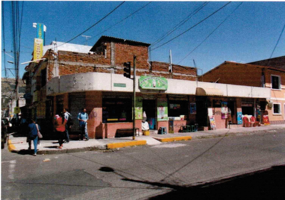
INTERSECCION CALLES SIMON BOLIVAR Y JOSE JOAQUIN OLMEDO (F-4): CONSTRUCCION EN H-A CON PAREDES DE LADRILLO Y CUBIERTA DE LOSA PLANA
