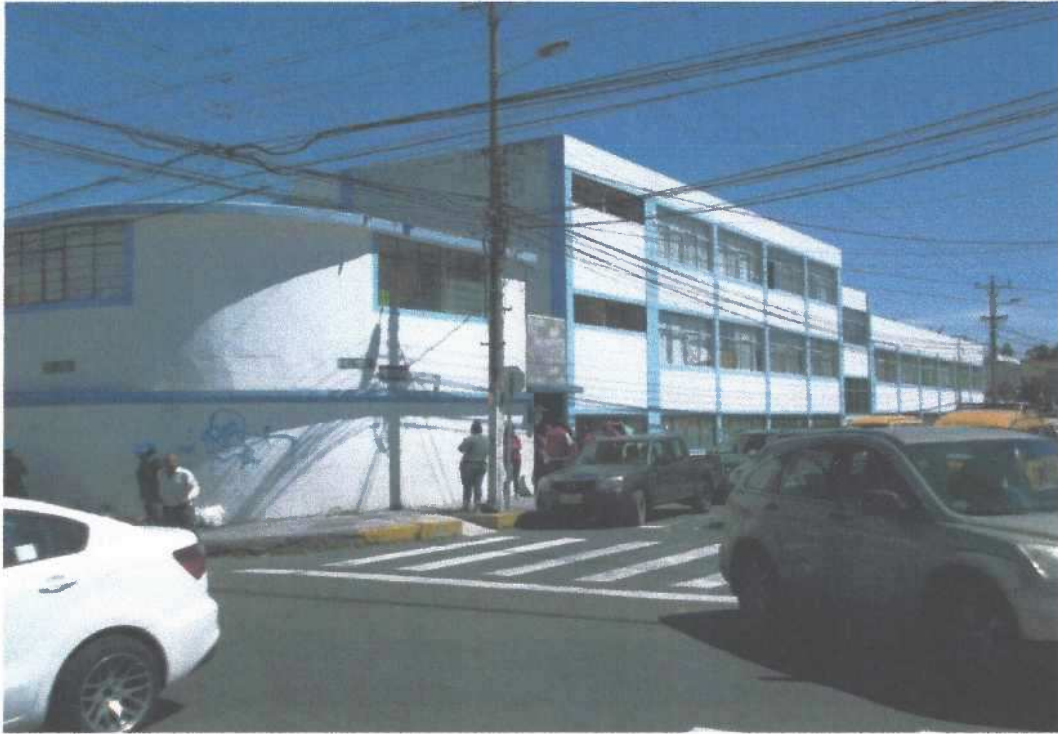
INTERSECCION CALLE MARISCAL SUCRE Y SIMON BOLIVAR ( F-19)
