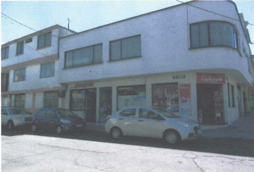
INTERSECCION CALLE LUIS PROAÑO Y MARISCAL SUCRE ( F-15)
