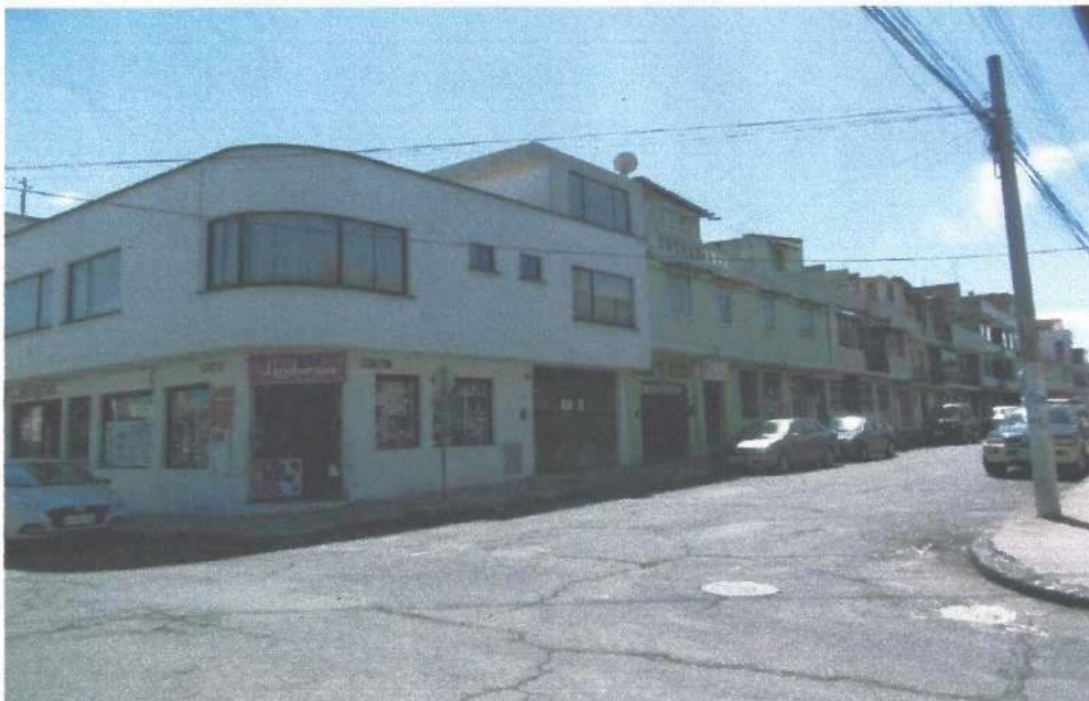
INTERSECCION CALLE LUIS PROAÑO Y MARISCAL SUCRE( F-14)
