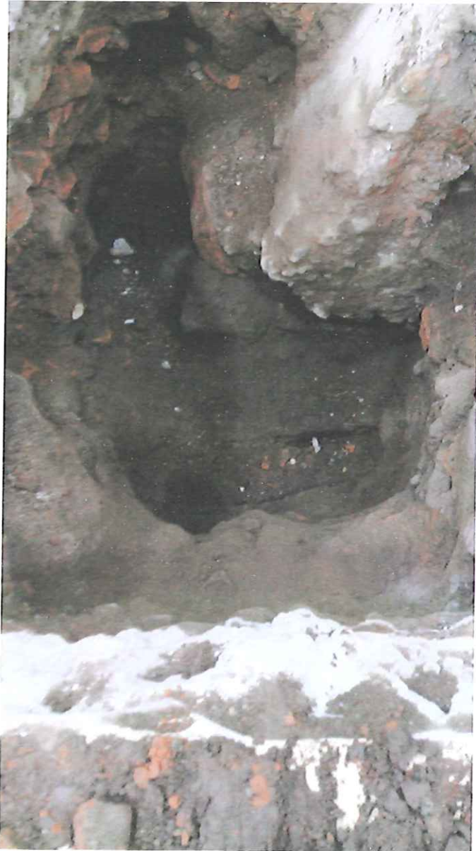
Profundidad de Cimentación 1.50 m.
