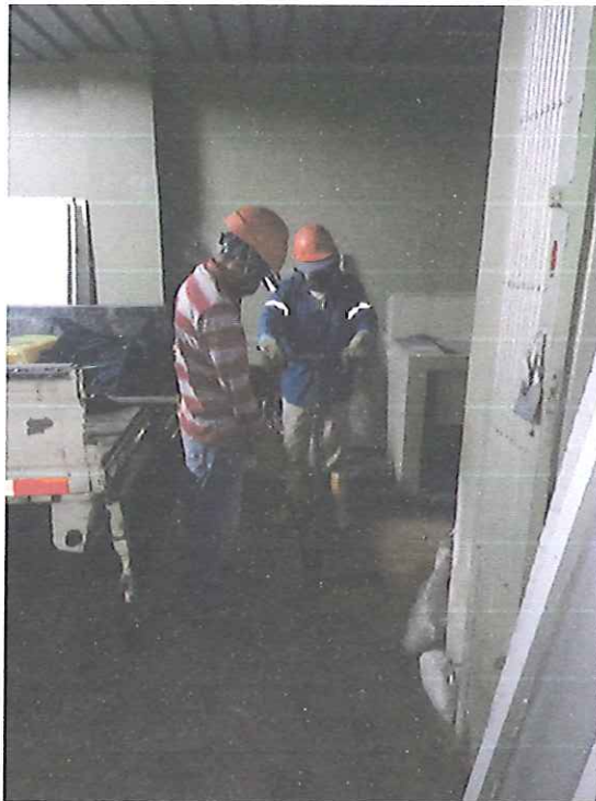
Perforación Manual con Auger
