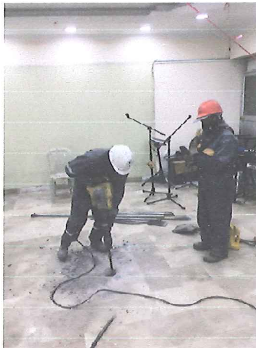
Perforación del Piso y Contrapiso
