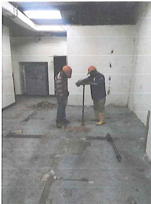
Perforación Manual con Auger
