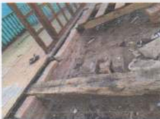
Elementos de piso del interior del restaurante
