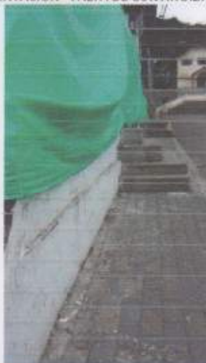
GRADAS DE ACCESO A LA PLANTA BAJA SOBRE LA ACERA
