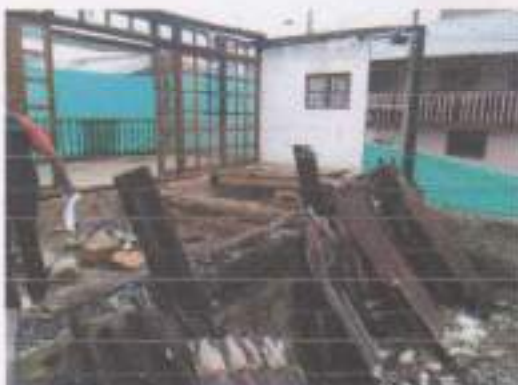
Elementos parciales de estructura de madera y mampostería
