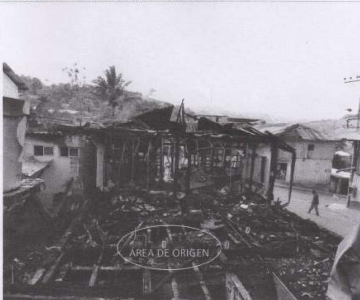
FOTOGRAFÍA N°2 : ÁREA DE ORIGEN DEL INCENDIO
