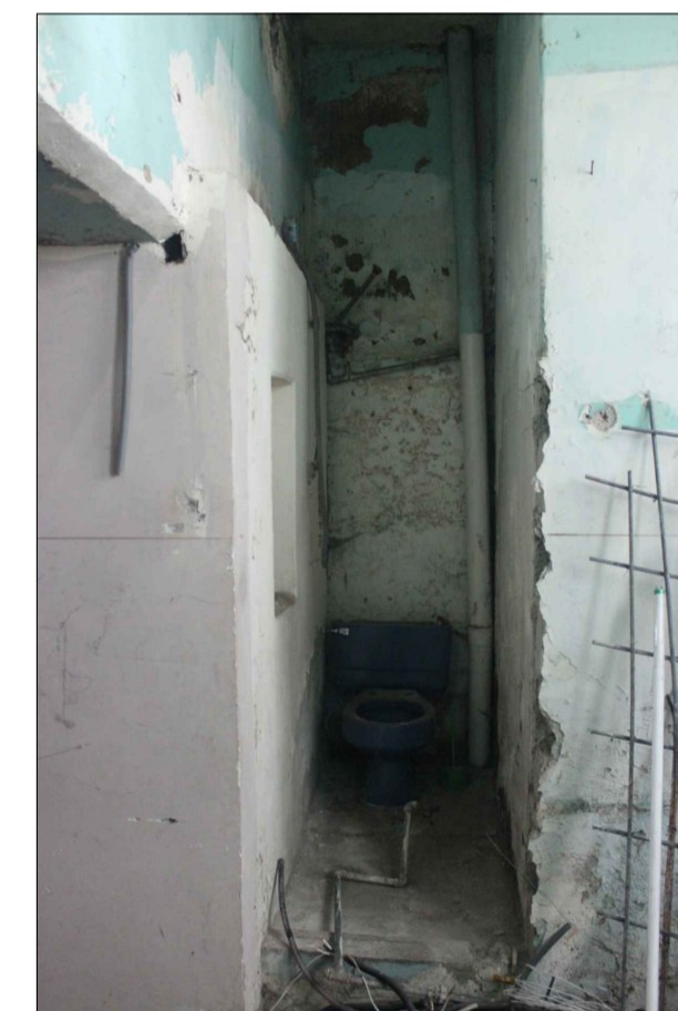
1 Planta baja, sanitario y lavabo añadidos sobre espacio de galería en torno a patio central.
