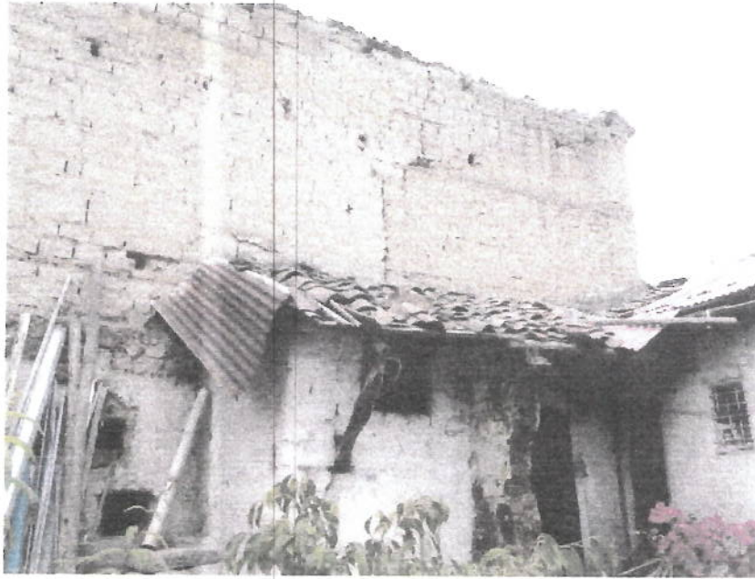
Edificación de un piso
