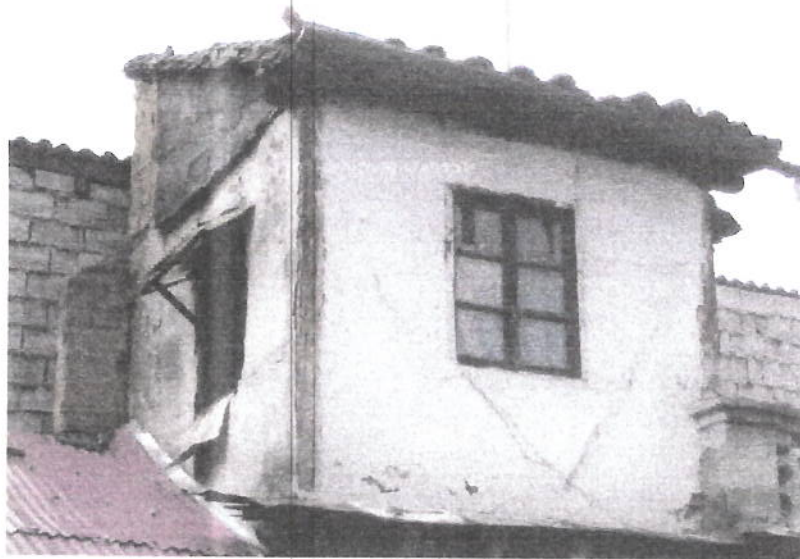
Ultima planta de la edificación de tres pisos, una pequeña habitación.
