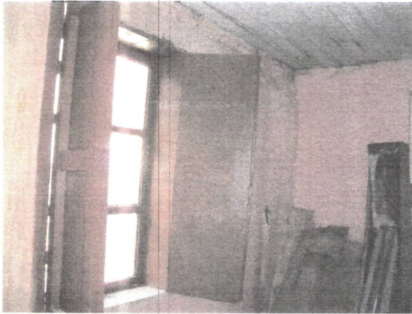
Tumbado de madera, ausencia de elementos decorativos
