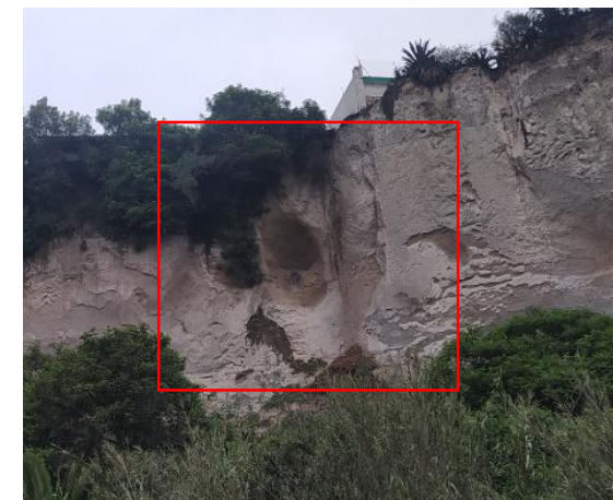
Foto No. 3: Inestabilidad de talud, erosión eólica.
