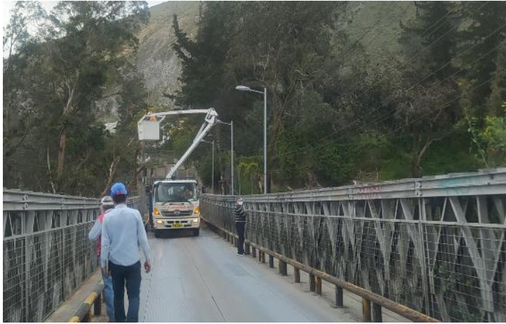
Foto No. 1: Estado actual y reforzamiento de puente la Marquesa.
