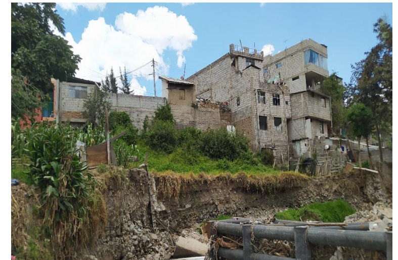
Foto No. 4: Viviendas en margen izquierda en zonas consideradas como de inundación.
