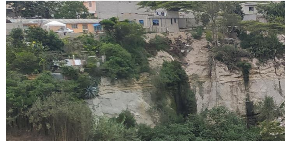
Foto No. 3: Viviendas al borde del talud.
