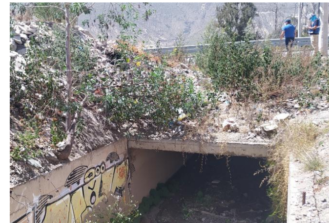
Foto No. 3: Posible taponamiento en estructura hidráulica.
