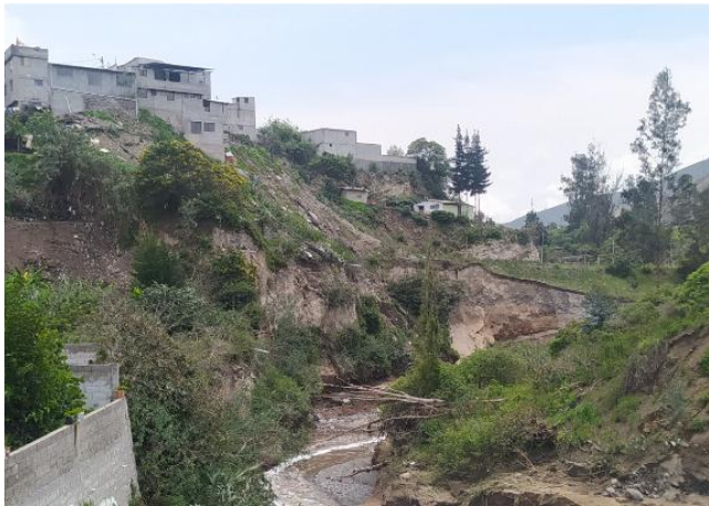
Foto No. 2: Viviendas en borde superior de talud.
