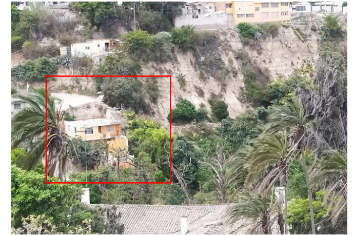
Foto No. 4: Viviendas ubicadas en franja de protección.
