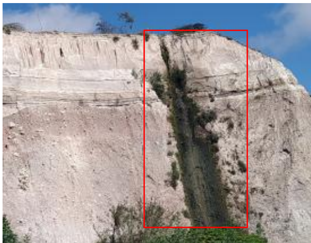
Foto No. 1: Saturación del suelo
