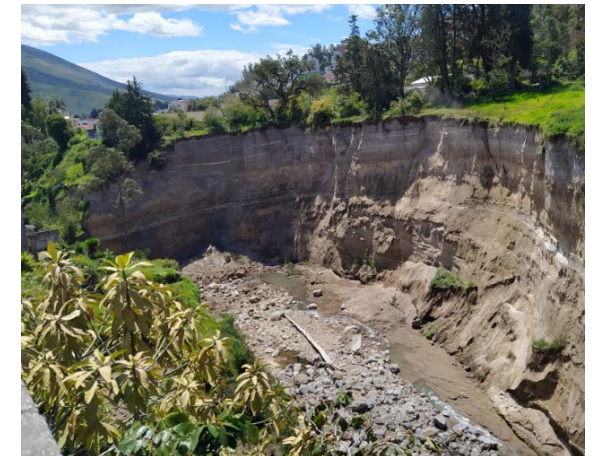
Foto No. 4: Inestabilidad de taludes-Márgenes Casa Hacienda)
