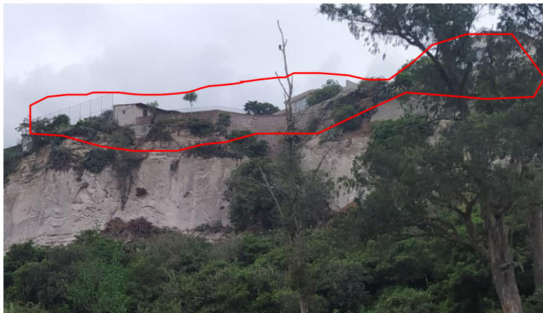
Foto No. 1: Viviendas en borde superior de talud.
