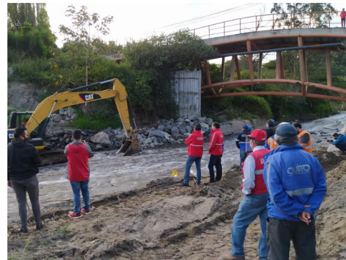
Foto No. 3: Colocación de piedra protección del puente-La Pampa.
