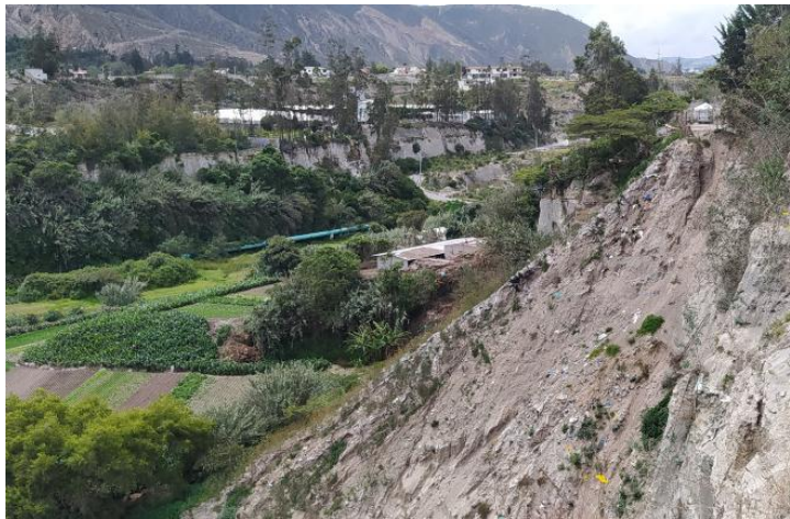
Foto No. 2 Rellenos antitécnicos, desviación de cauce natural
