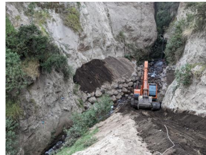
Foto No. 4: Colocación de piedra en márgenes en el sector Puertas del Sol- Quebrada Carretas, julio 2021.
