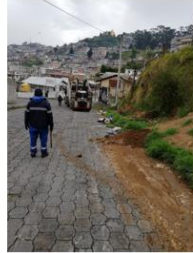
Limpeza de Cunetas Batea – La Sofia
