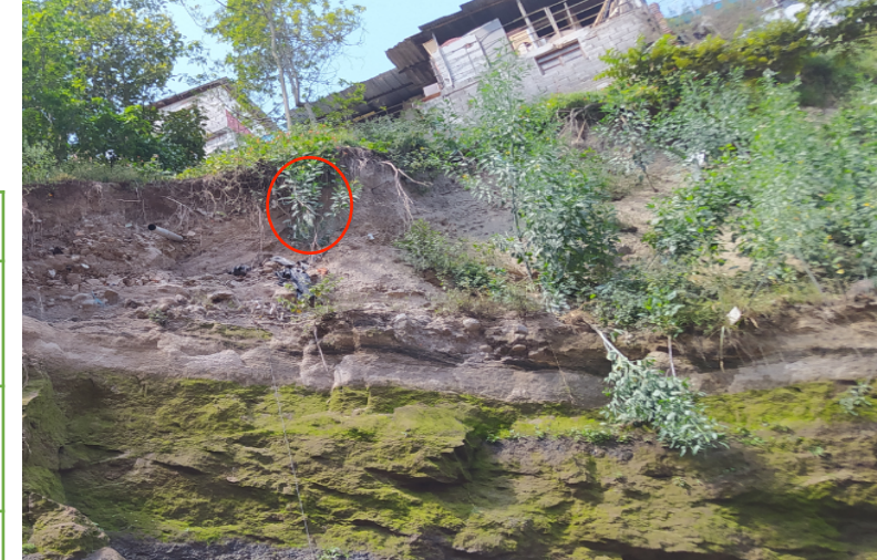
Control de descargas directas al cauce
