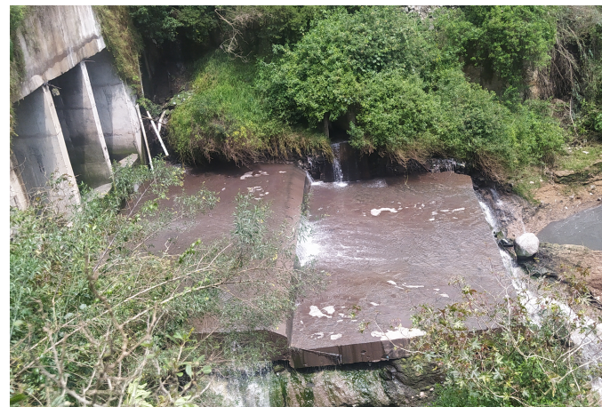
d. Falla de viga de hormigón armado-muro Pfizer.
