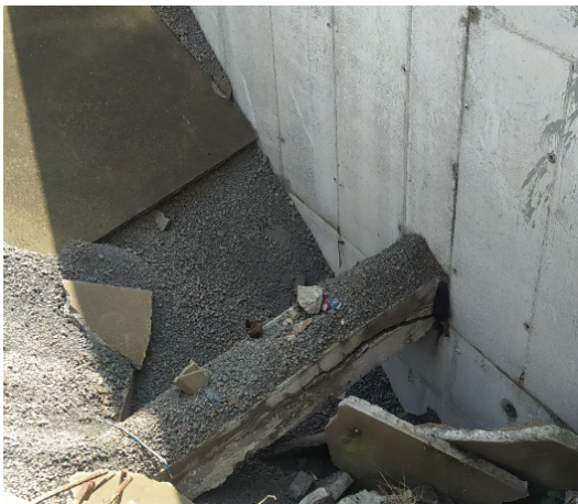
d. Falla de viga de hormigón armado-muro Pfizer.
