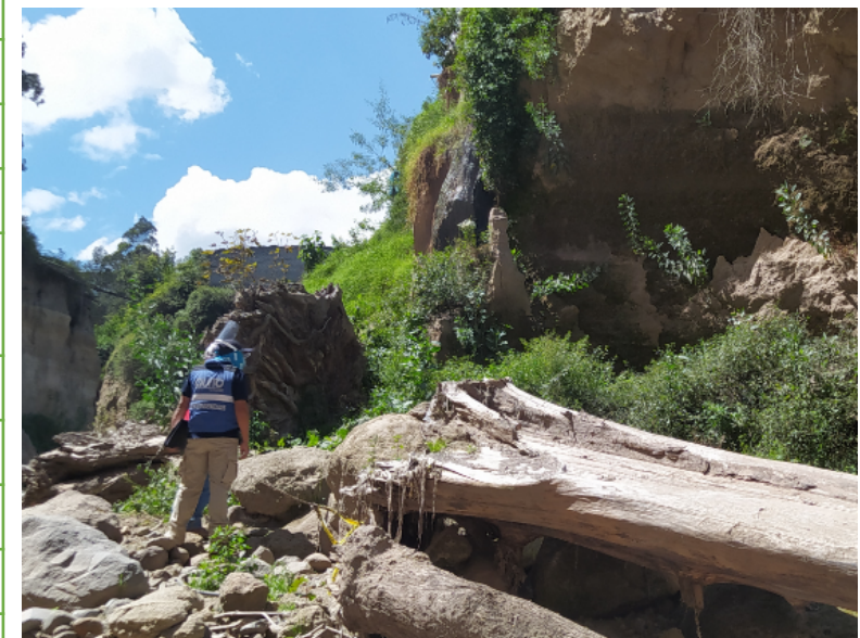
Limpieza de cauce (árboles muros colapsados)
