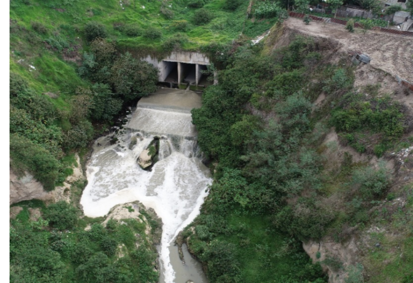
Ejecutar obras complementarias en la estructura hidráulica
