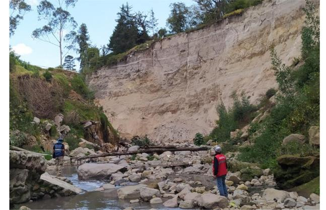
Taludes expuestos a erosión eólica e hídrica aguas abajo del deslizamiento en el 2021.
