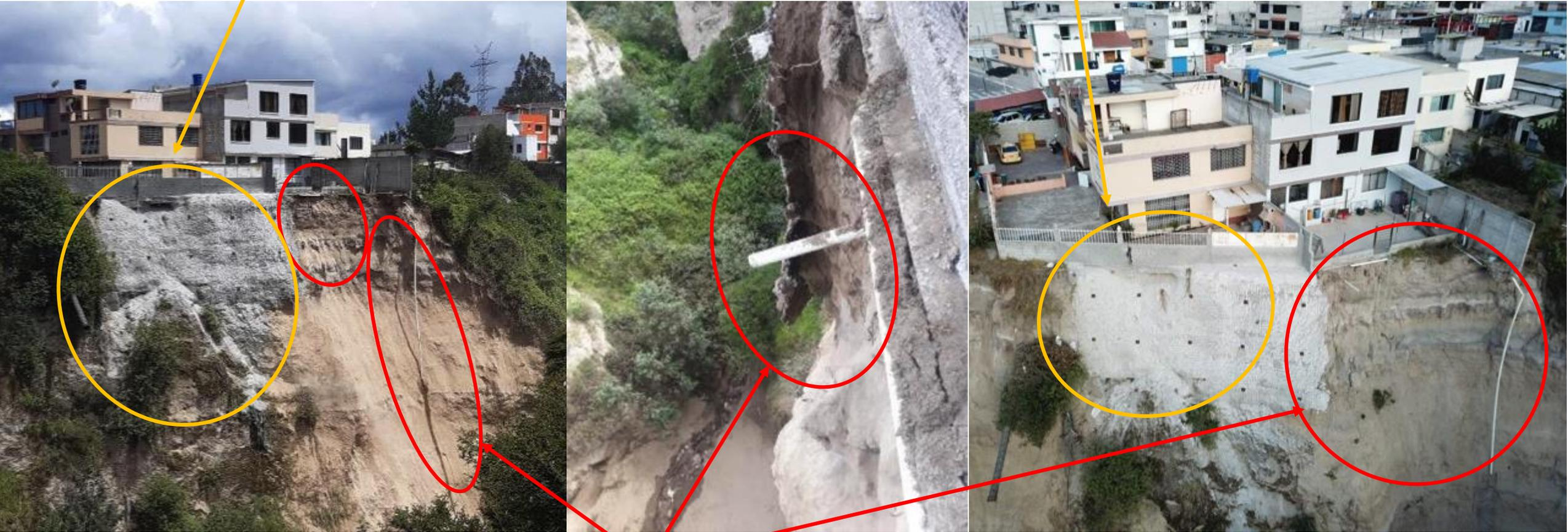
Descargas de agua sobre el talud predio **3541161**
