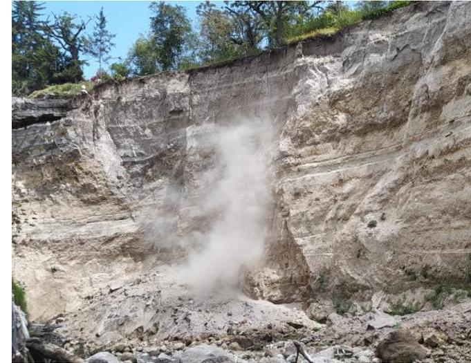
Inestabilidad de talud, debido a la acción eólica (margen derecho)
