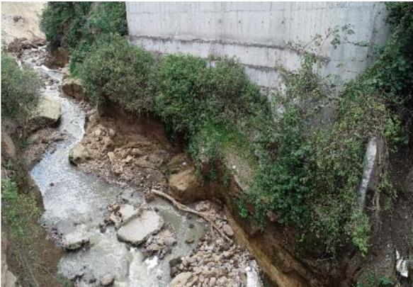
Socavamiento bajo las bases del muro
