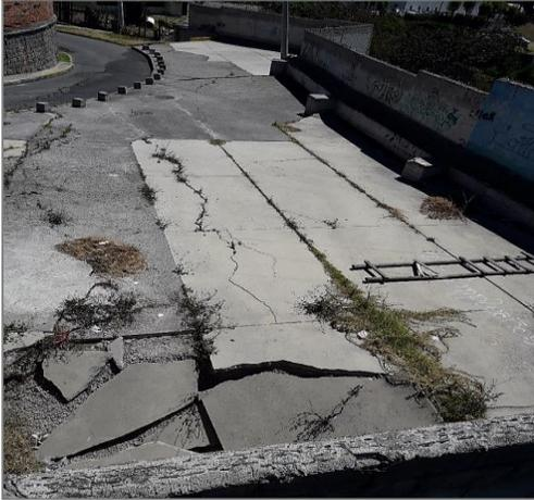
Daños y asentamiento del contrapiso sobre muro
