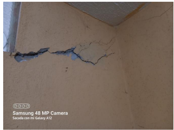
Fotografía No. 6: Interior de vivienda en predio 3502007. Se observa desprendimiento de enlucido en mampostería.
