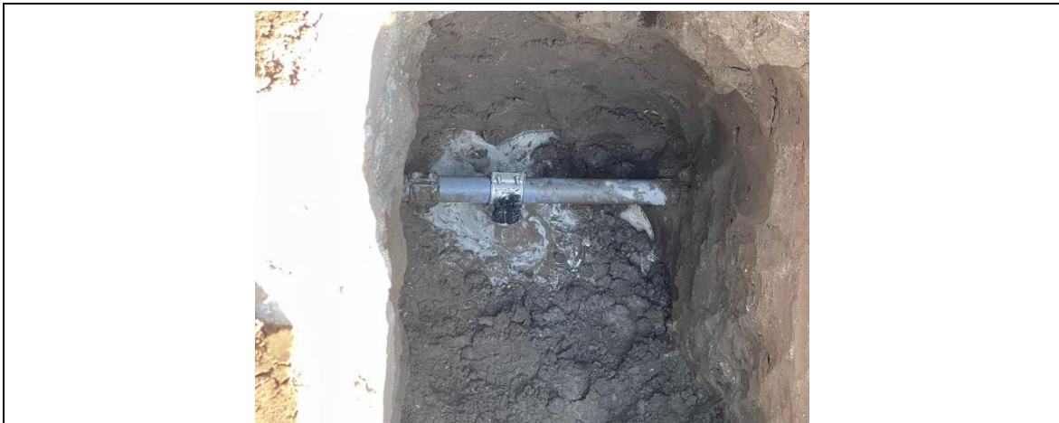
Fotografía No. 19: Excavación y tubería de agua reparada en el exterior del predio 3502007.
