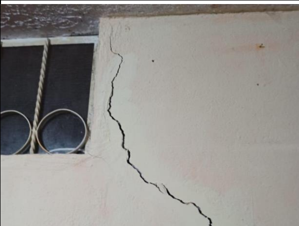
Fotografía No. 7: Interior de vivienda en predio 3502007. Se observa desprendimiento de enlucido en mampostería.
