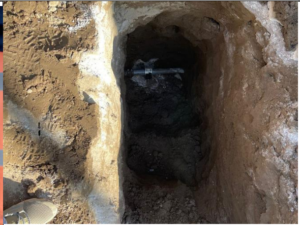
Fotografía No. 18: Excavación y tubería de agua reparada en el exterior del predio 3502007.
