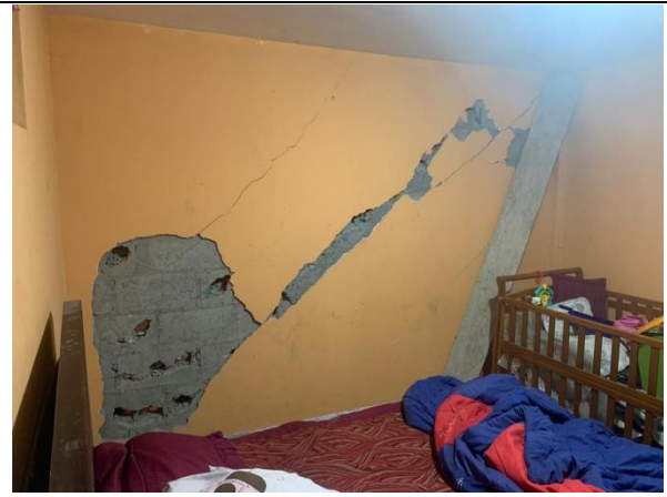
Fotografía No. 6: Interior de vivienda en predio 3502007. Se observa desprendimiento de enlucido en mampostería.
