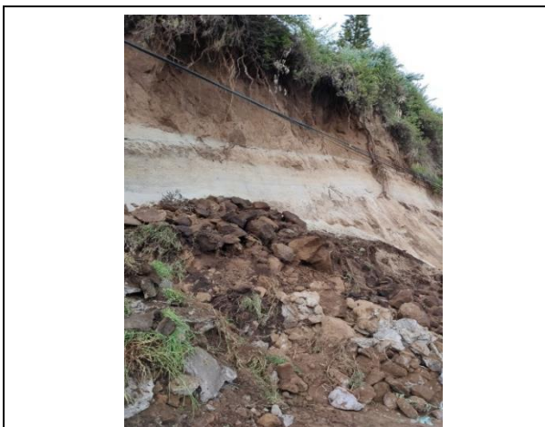
Foto No.5 Capa de pómez en talud, esta fue protegida ante la erosión eólica, por un calce de piedra.
