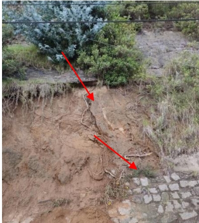
Foto No.7 Las raíces del árbol de eucalipto están forzando al recubrimiento de piedra, dejando sin adherencia contra el suelo, y pase el agua por estos sitios.
