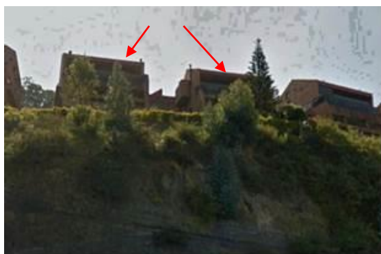
Foto No.1 Vista panorámica de la ubicación del Edificio Antisana, que está conformada por dos bloques.
