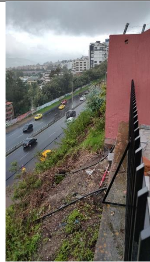
Foto No.12 El retiro del talud hacia el cerramiento, es menor de 1 metro.
