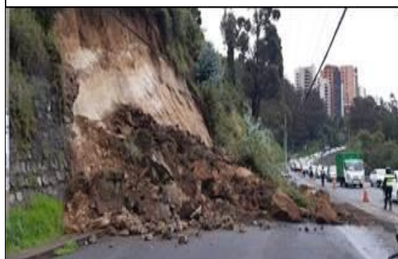
Foto No.2 Caída de bloques de tierra, raíces y material de calce, hacia la Av. Mariscal Sucre
