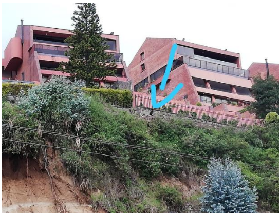
Foto No.9 Las aguas lluvias de los jardines en la planta baja de la edificación, son evacuadas hacia el talud, por mechinales.
