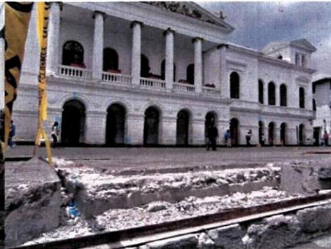
Imagen 6. Desprendimiento de piedra y revestimientos de piso
