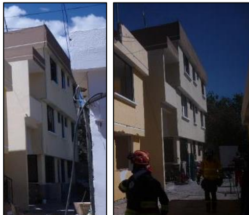
Foto 6.4: Tercera edificación del lote uno visitado (Predios No.: 3627319, 3627327, 3627325, 3627323, 3627321).
