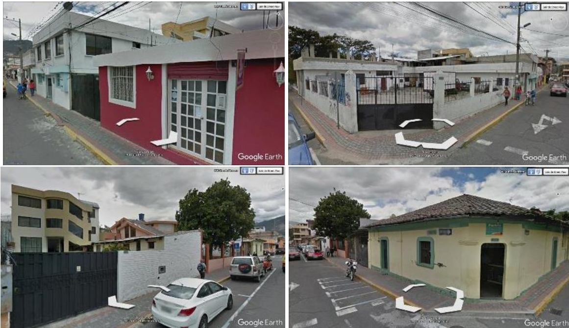
Foto 6.1: Vista del sector afectado, previo a la emergencia (Fuente: Google Earth, 2014).
