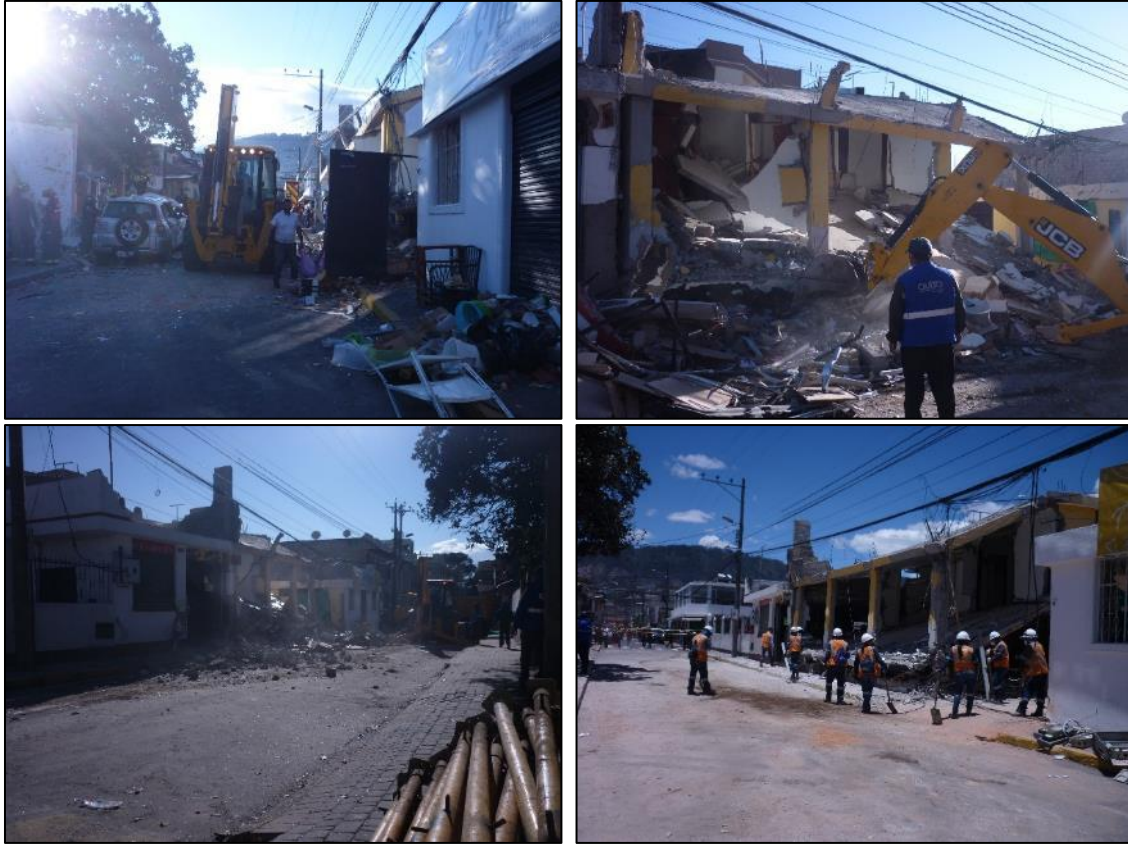
Foto 6.9: Retiro de escombros.
