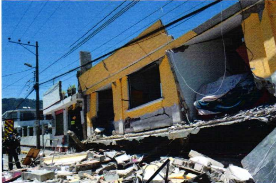
Fotografía 20: Pared lado SUR
