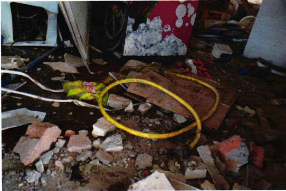
Fotografía 22: Manguera de gas conectada a una llave de paso.
