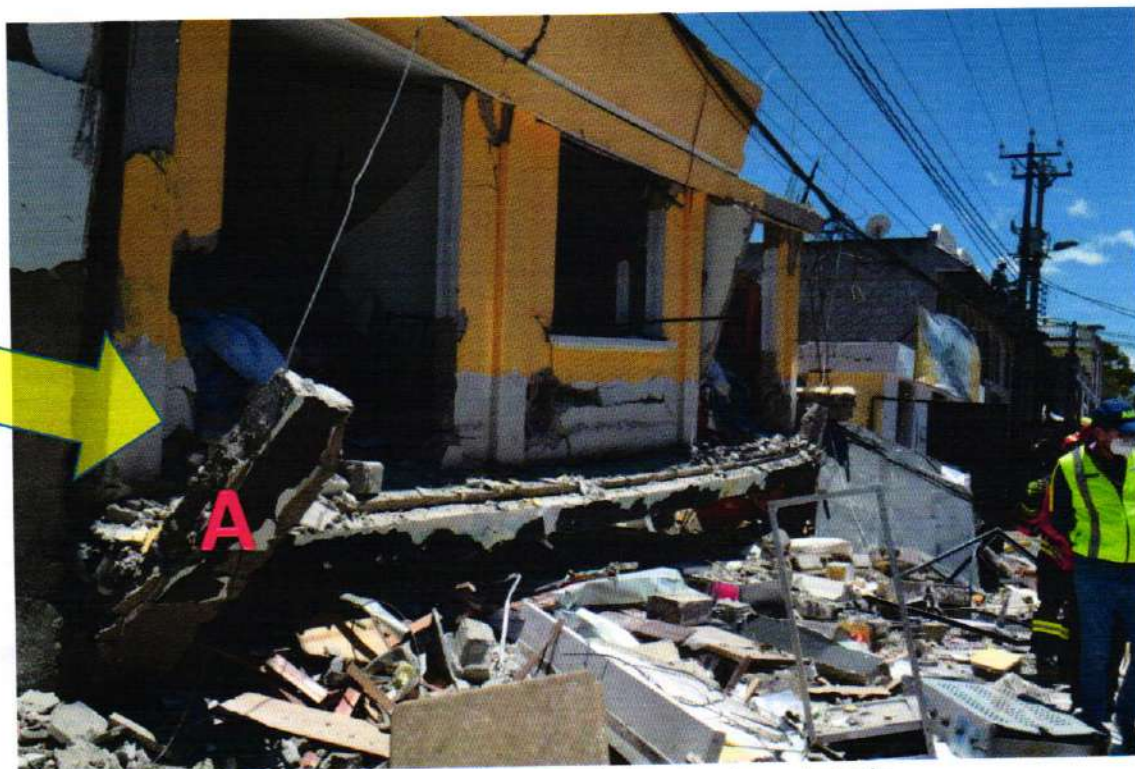
Fotografía 14: Columna A de la estructura afectada.
