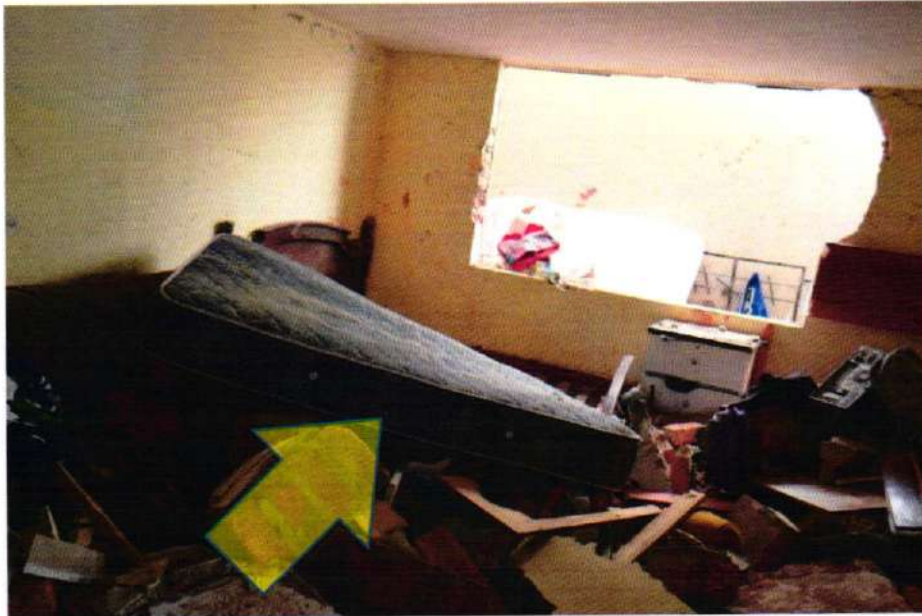
Fotografía 18: Pared lado NORTE
