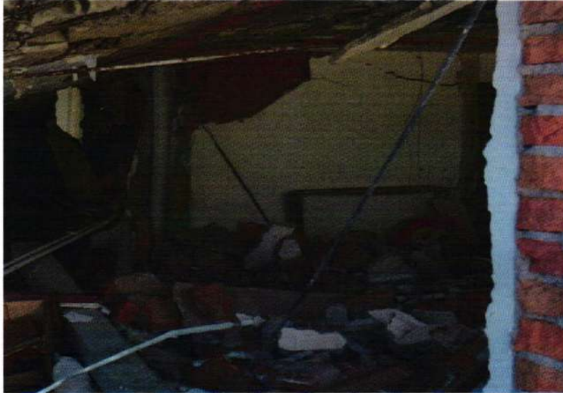
Fotografía 19: Pared lado este
