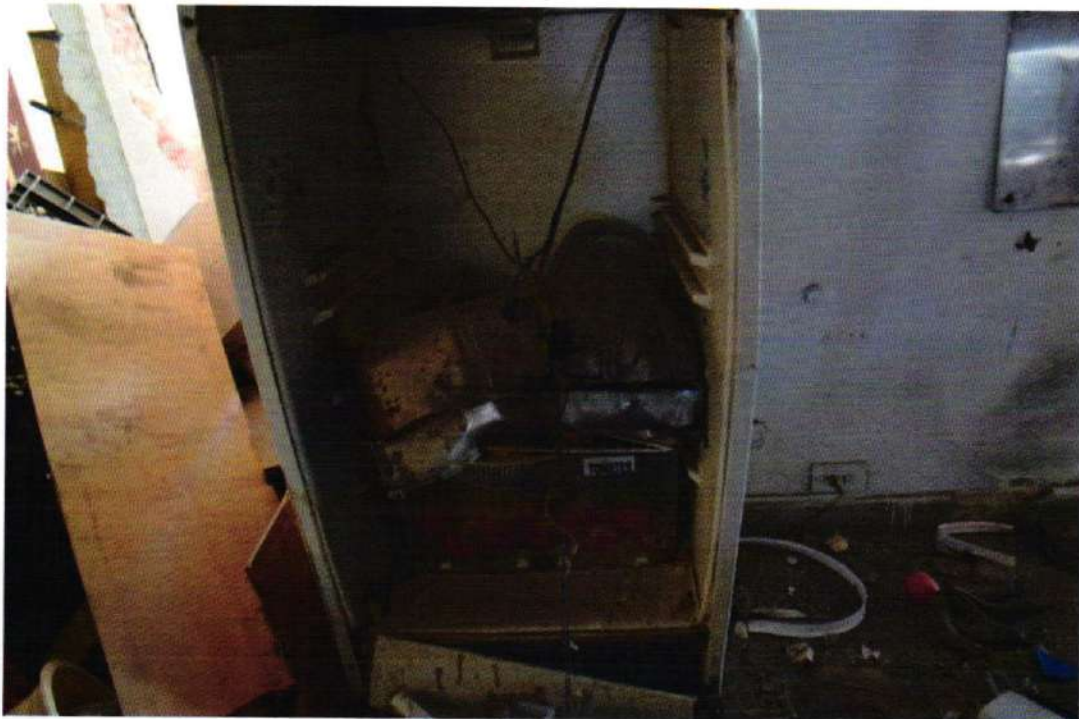
Fotografía 29: Refrigerador de alimentos
