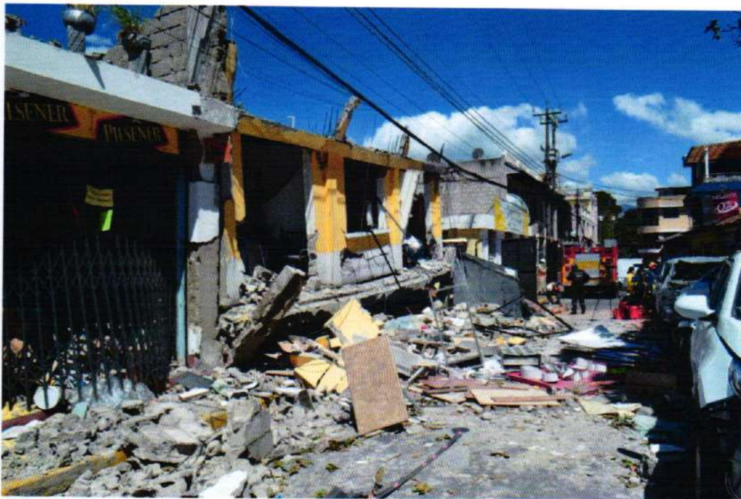
Fotografía 4: Vivienda de dos pisos completamente afectada estructuralmente.
