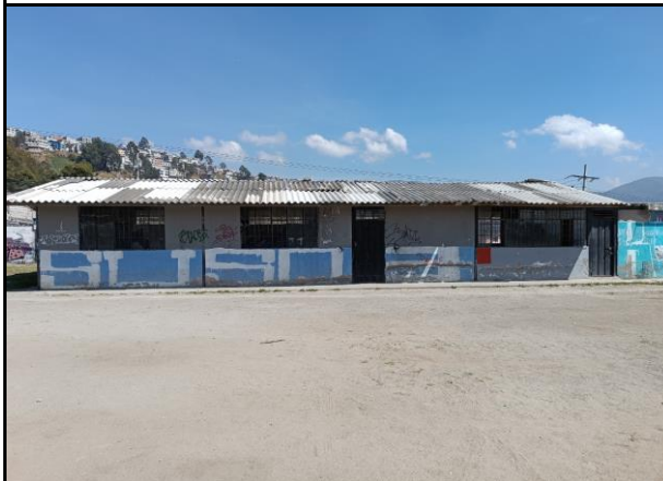
Foto 7: Construcción de un piso
