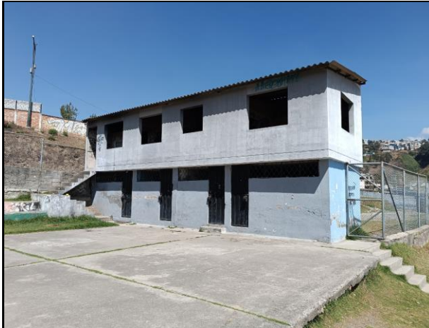
Foto 3: Construcción de dos pisos
