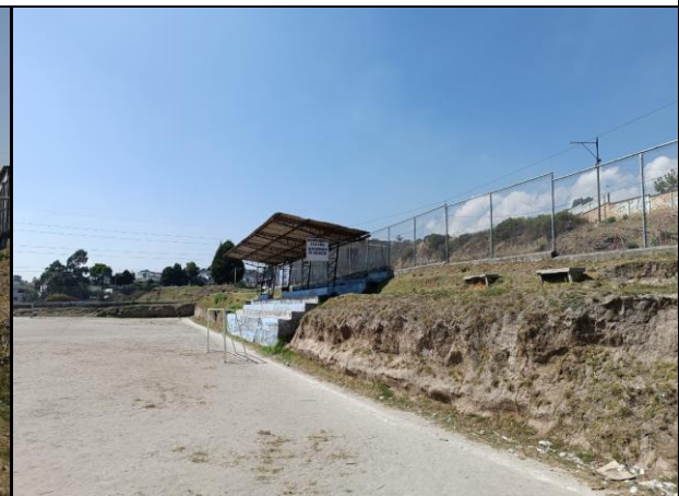
Foto 2: Graderío cancha Oeste
