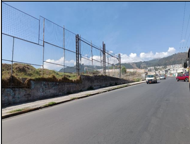
Foto 5: Cerramiento y acceso cancha Oeste, Calle Yanacona N74
