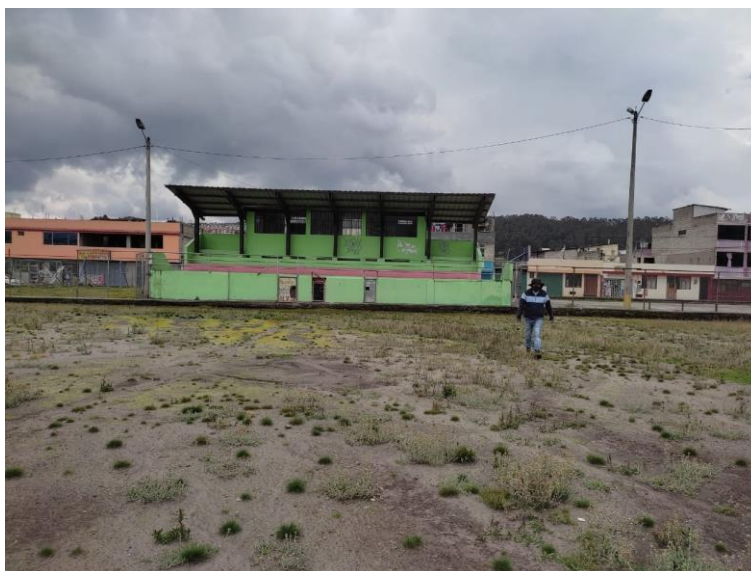
Fotografía 3. Graderío y visera
