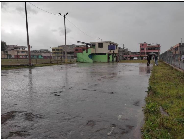
Fotografía 2. Cancha de uso múltiple
