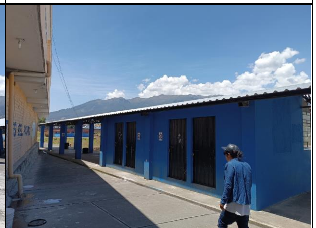
Foto 8: Cabinas de locución
