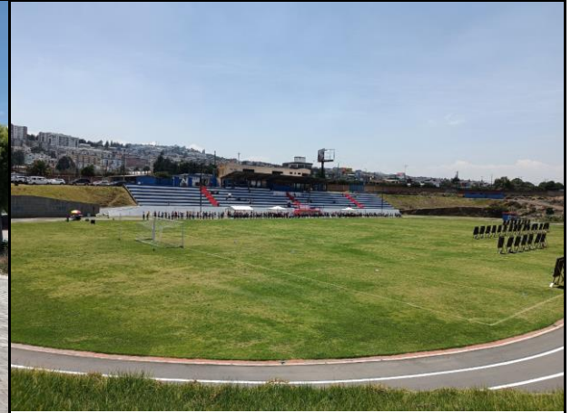
Foto 4: Cancha principal y graderío parcialmente cubierto.
