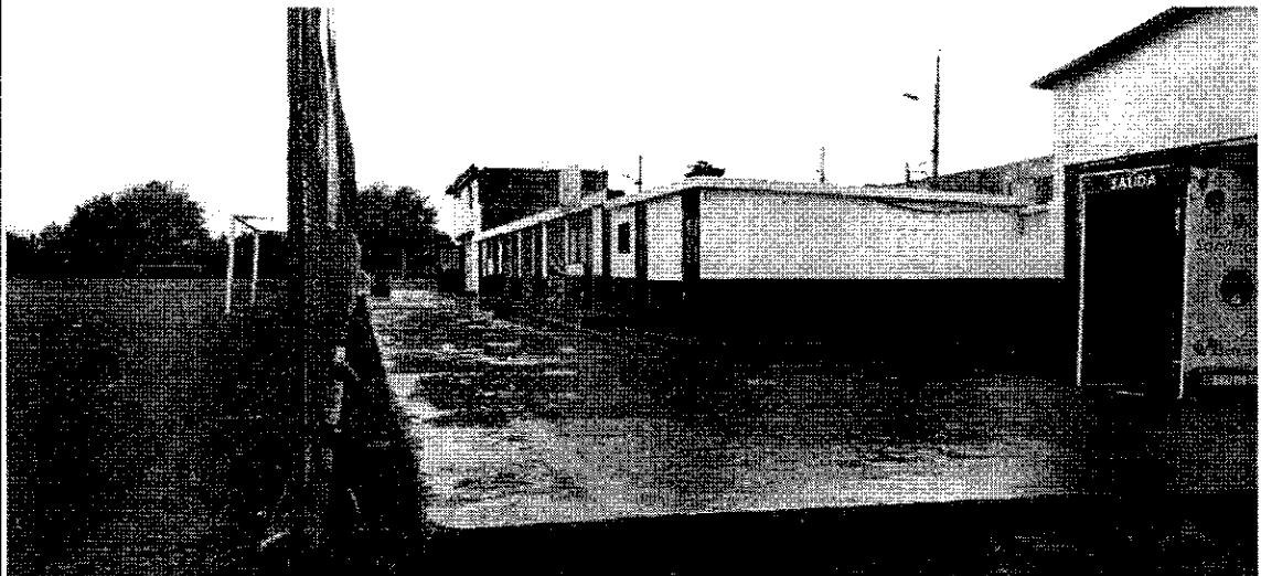
Fotografía 2. Baterías sanitarias y bares
