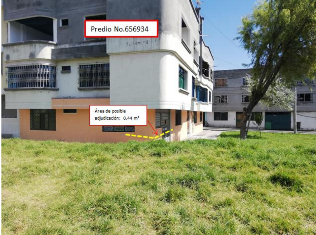
Fotografía 2: Ocupación del área a adjudicarse (relleno de quebrada).
