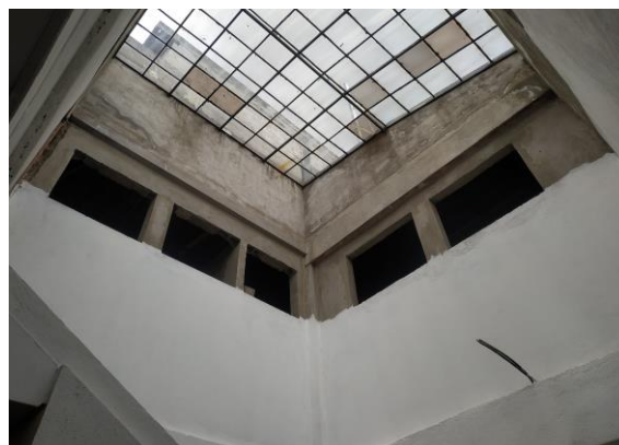
Imagen 3. Estructura en construcción
