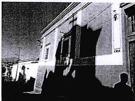
Vista - Fachada Lateral
