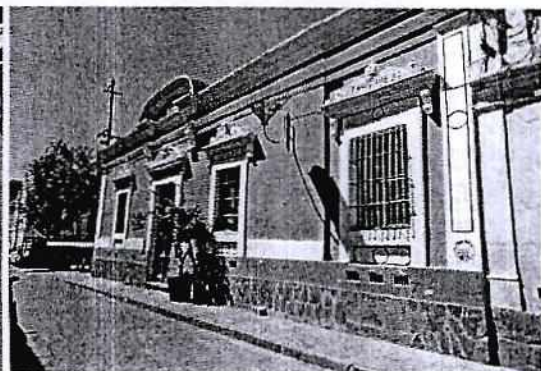
Vista - General del Inmueble.
