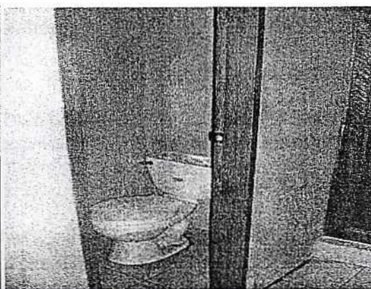
Vista 2- Baterías Sanitarias
