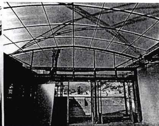
Vista – Cubierta Patio Central
