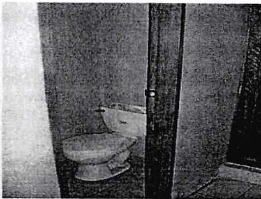
Vista 2- Baterías Sanitarias
