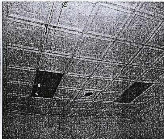
Vista 2- Cielo Raso
