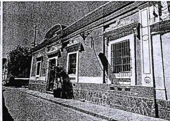
Vista – General del Inmueble.
