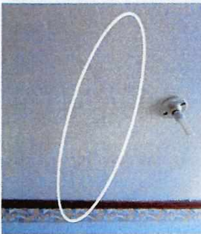
Se observan las fisuras en la mampostería de paredes y techos, dentro de la edificación ubicada en colindancia con el relleno, que podrían ser indicios de asentamiento
