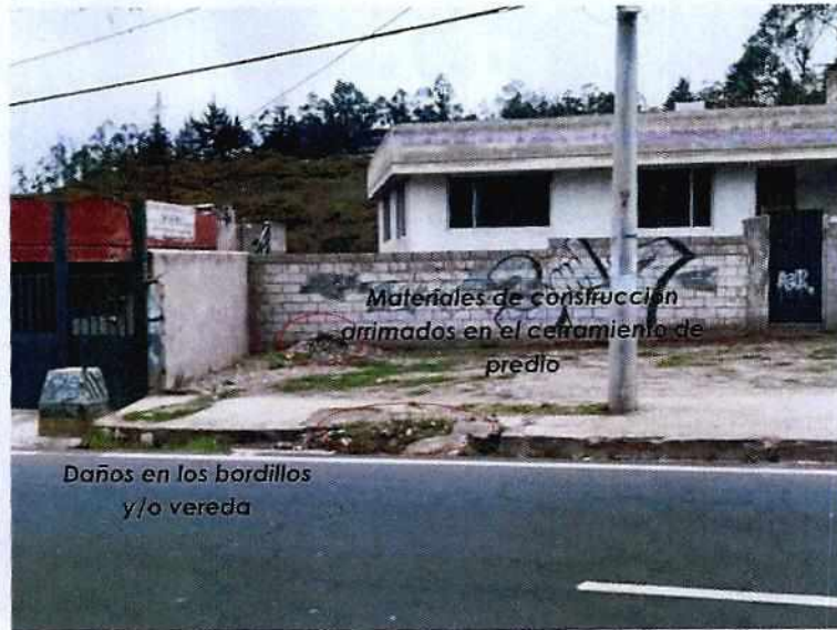
Fachada frontal de Predio
