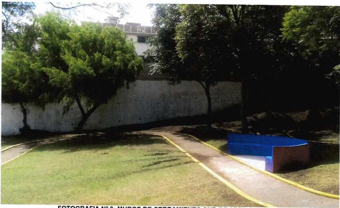
FOTOGRAFIA N° 6: MUROS DE CERRAMIENTO SUR DE AREA COMUNAL
