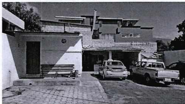
Fotografías de Inspección
