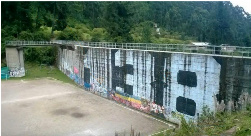
FIG.16. ESTANQUE DE RETENCIÓN QUEBRADA RUMIPAMBA
