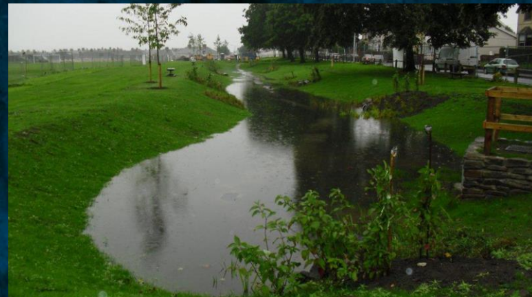
FIG. 23. Almacenamiento temporal de aguas lluvias en depresiones naturales y artificiales de parques
