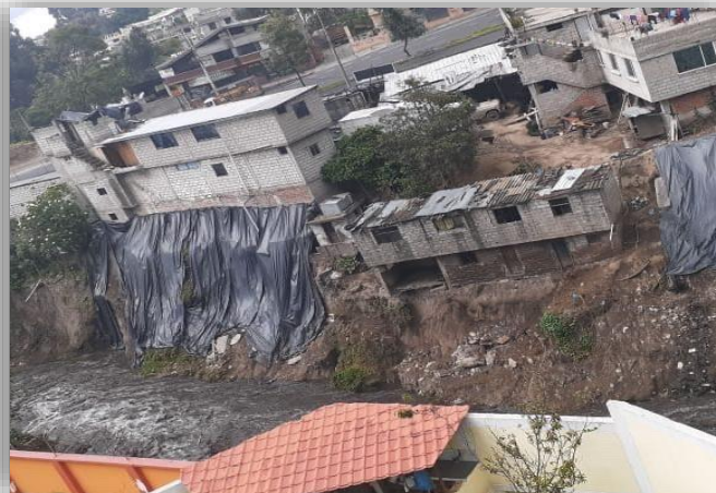
FIG.4. VIVIENDAS EN FRANJA DE PROTECCIÓN DEL RÍO MACHÁNGARA, SECTOR VALLE DEL SUR
