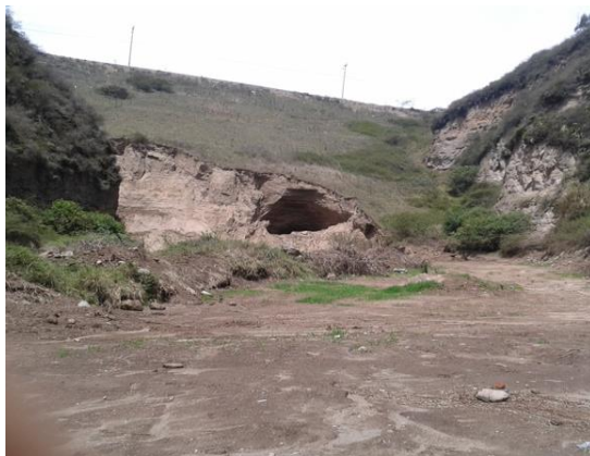
10. Colapso de Alcantarilla vial – Av. Simón Bolívar – cauce qda. Chaquiscahuaycu -2013
