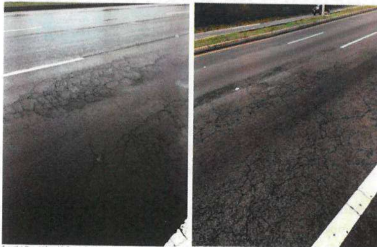
Gráfico No. 1: Fotos de la calzada de la Ruta Viva
