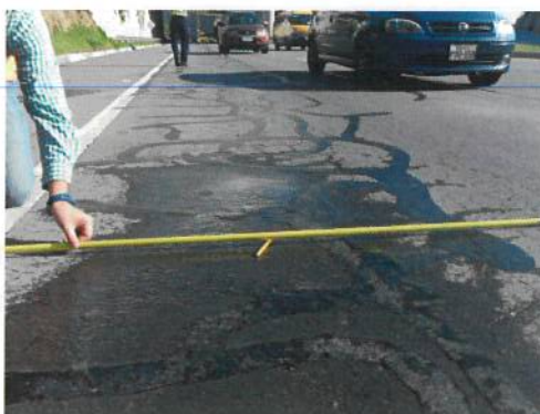
Gráfico No. 3: Ahuellamientos en la vía
