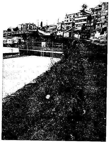
Adicionalmente, cabe indicar que al momento no se presentan señales de que el talud esté fallado ya que no se ven fisuras en la calzada, sin embargo hay presencia de socavamientos en el paramento vertical que podrían generar caídas en bloque del talud, dado el tipo de suelo de la zona.
