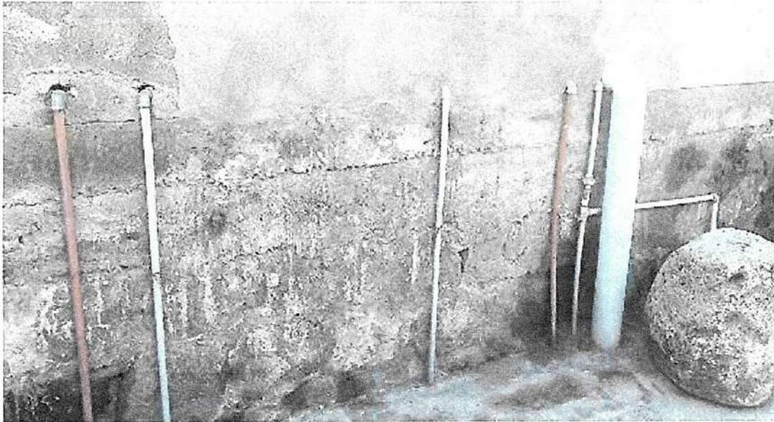
Acceso inadecuado al agua potable; se evidencian conexiones informales expuestas
