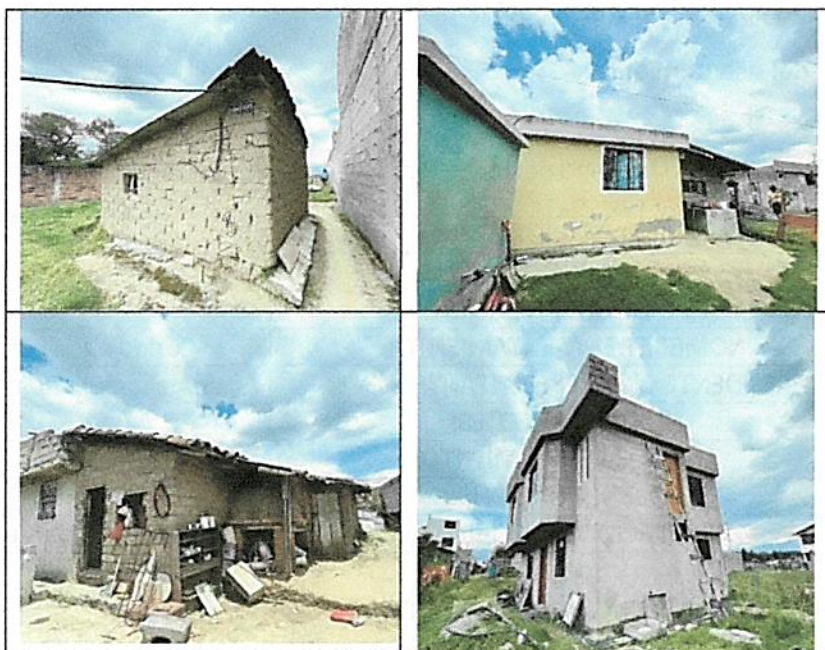
Gráfico 2. Vivienda con calidad estructural reducida del AHHyC “Curiquingue I Etapa”.
