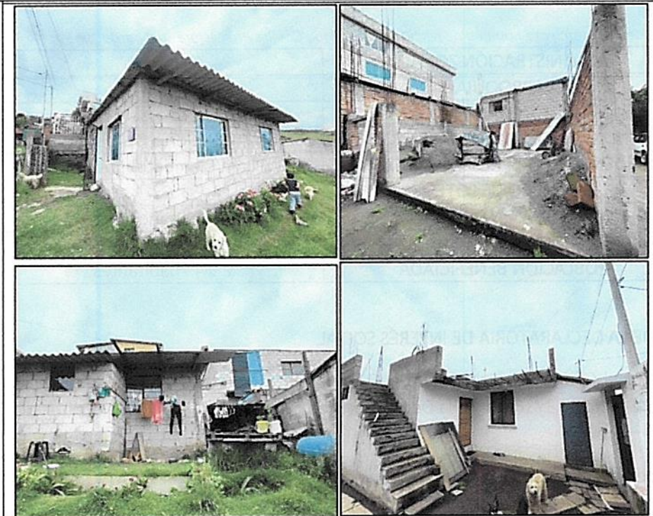
Gráfico 4. Vivienda con calidad estructural reducida del AHHyC denominado Comité Pro Mejoras barrio "La Paz".
