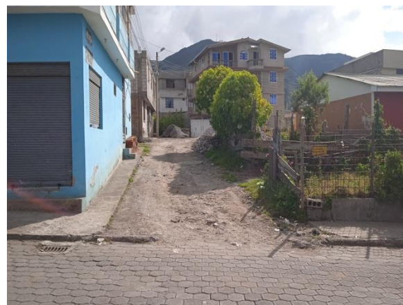
Imagen 7. Estado actual pasaje S48D
