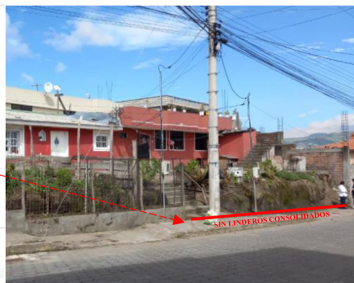
FOTOGRAFIA OBTENIDA EN INSPECCION EN CAMPO
