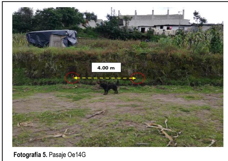
Nota. El pasaje Oe14G cuando se realizó la inspección no se encontró aperturado; sin embargo, se encuentra definido su ancho vial de 4.00 metros con estacas de madera y varillas.
