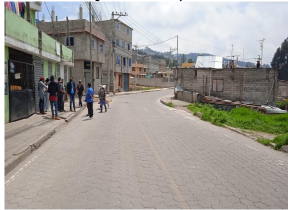
Fotografía Nro. 10: Calle principal Santa Isabel (Oe5D)
