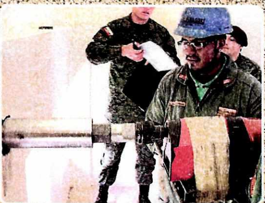
Patologías de la construcción: extracción de núcleos, mampostería, filtraciones, obras de protección.
