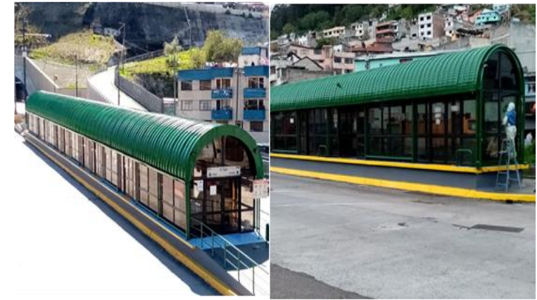
Mejoramiento de Infraestructura de Paradas Corredor Sur Occidental / Ecovía
