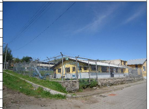
FOTOGRAFÍA DE LA FACHADA
