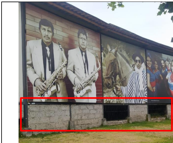
Fotografía 3. Mampostería sin enlucidos.
