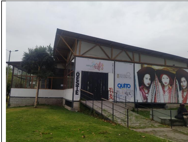
Fotografía 1. Estructura de Pabellón de las Artes.
