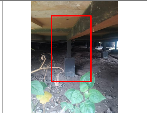
Fotografía 2. Cimentación de estructura
