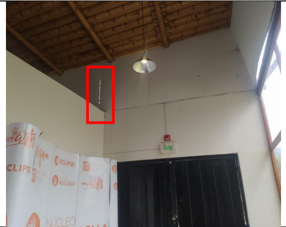
Fotografía 7. Separación entre planchas de madera que funciona como mampostería.
