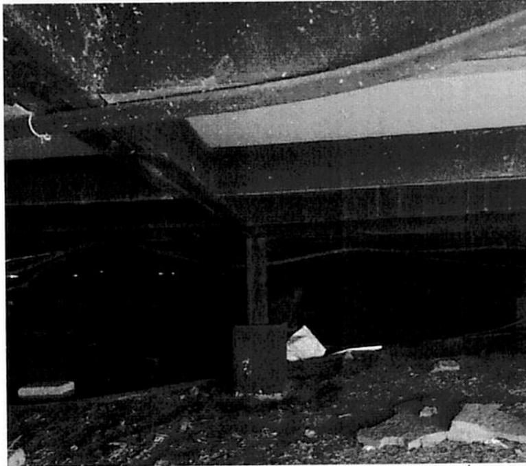
FOTOGRAFÍA 2: ESTRUCTURA METÁLICA SOBRE PLINTOS DE HORMIGÓN
