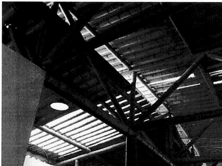
FOTOGRAFÍA 4: ESTRUCTURA DE CAÑA PARA CUBIERTA
