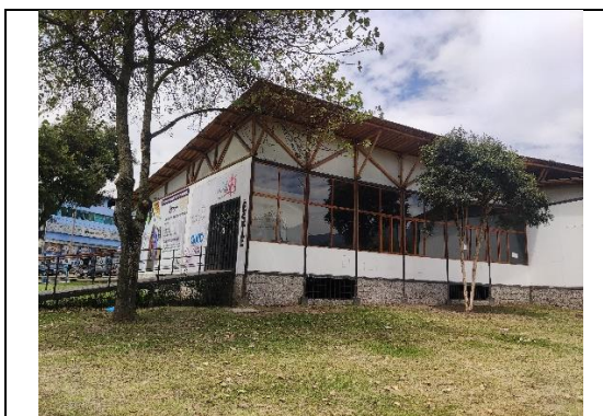
Fotografía No. 01 Ingreso Pabellón de las Artes
