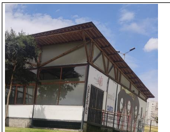
Fotografía No. 10 Pasamanos lado oeste.
