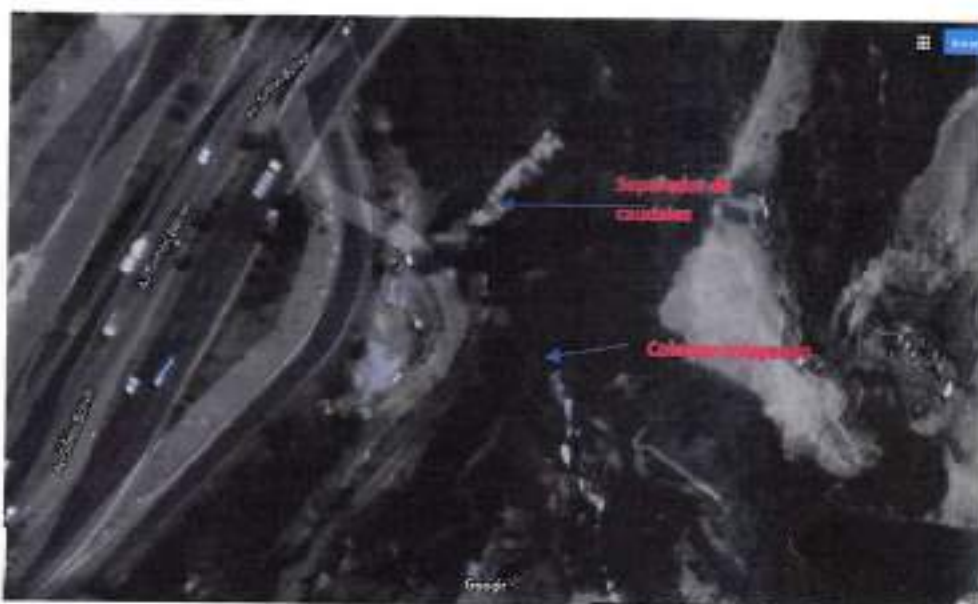
Fotografía N°1: El colector se encuentra implantado en la calle Quito y Av. Simón Bolívar
