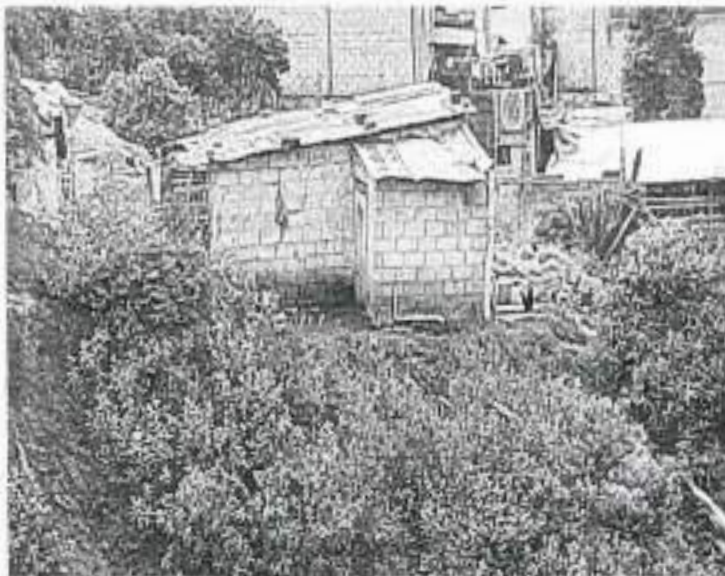
VIVIENDA LOCALIZADA CERCA AL TALUD
