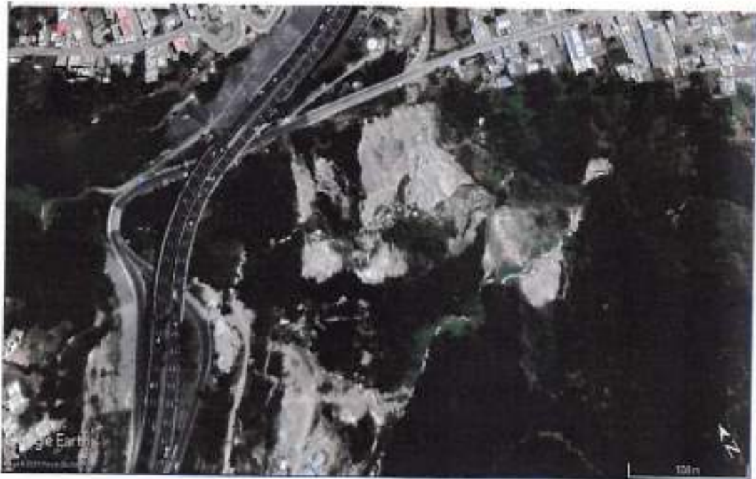
Fotografía N°2: Quebrada Zámbara, año 2020
