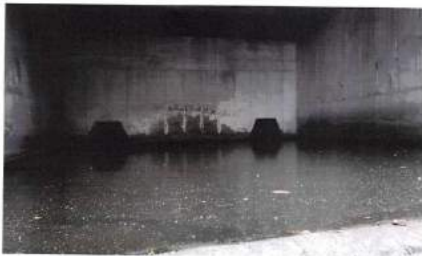
Fotografía N°8. Separador de caudales (colchón de agua; profundidad aproximada 1.50m)
