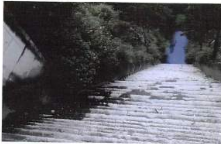
Fotografía N°7. Separador de caudal y descarga en graderío Quebrada Zambiza
