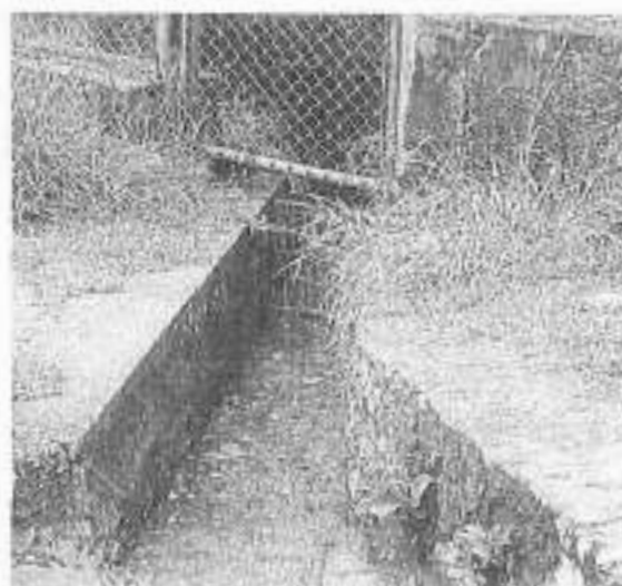
CANAL DE HORMIGÓN (PREVIO A LA DESCARGA EN QBDA.)
