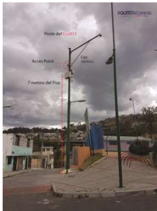
Ejemplo de cómo se realizó Instalación de puntos en Poste del Ecu911 en parque de la Bota.
