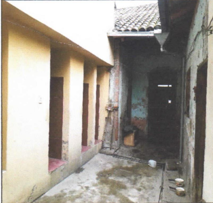
VISTA DESDE EL PATIO HACIA EL INGRESO CONSTRUCCIÓN AÑADIDA
