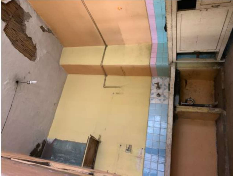
VISTA PARED COCINA
