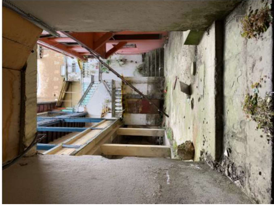
VISTA DESDE EL ZAGUAN PLANTA BAJA
