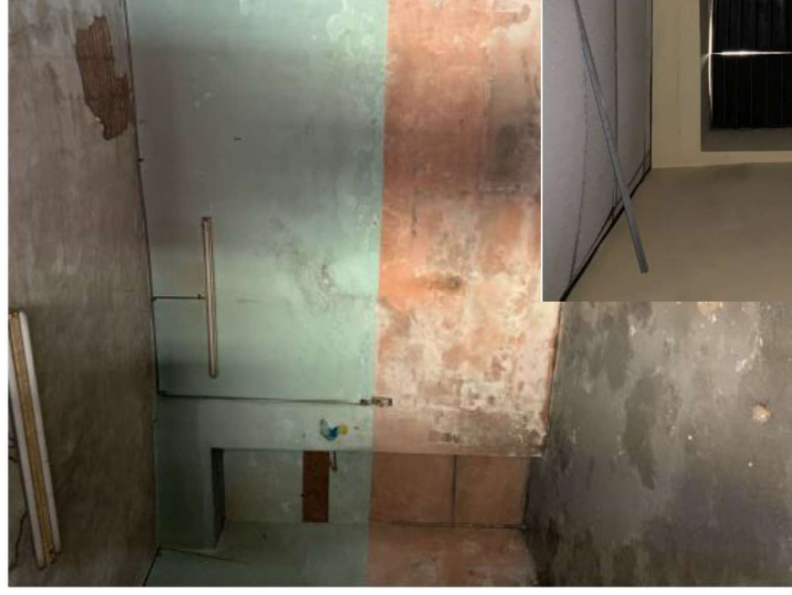
VISTA INTERIOR HABITACIONES
